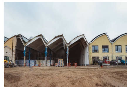
Dalum Papirfabrik: Omdannelse af eksisterende bygningsmasse
